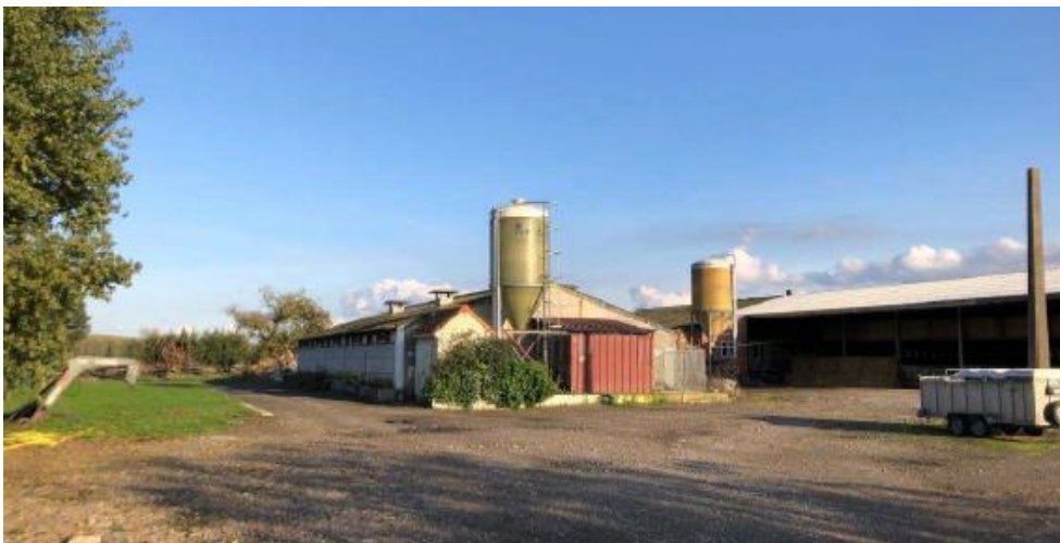
Figure 8. Vue après projet du bâtiment P11 (Source : DMB Conseils)
